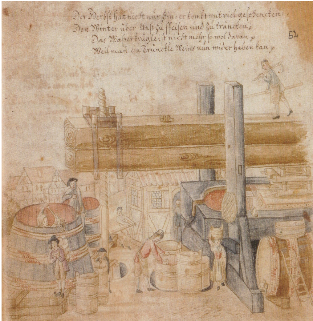
Großer Kelterbaum zum Pressen der Trauben. Zeichnung aus dem Jahr 1718 von Daniel Pfisterer aus Köngen
